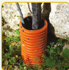
Manchons de protections des plantations
